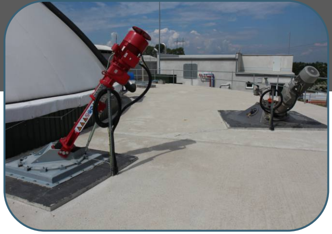
míchadla hlavního fermentoru a dofermentoru
