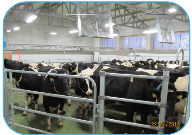
v čekárně jsou axiální ventilátory
