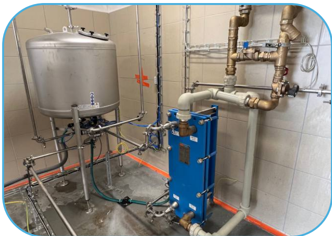
buffer tank 300 litrů a deskový předchladič mléka
