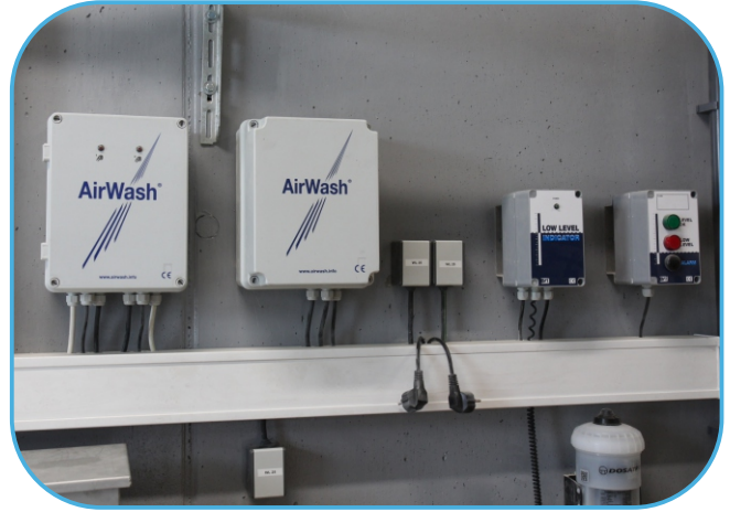
systém AirWash automatické proplachování návleček
