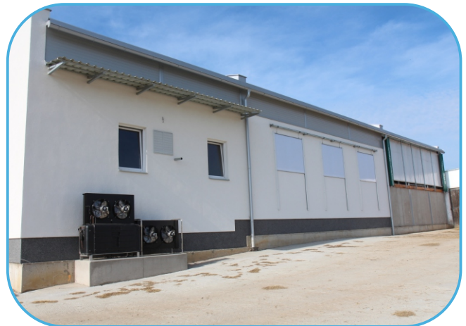
budova dojírny a čekárny se svinovací plachtou
