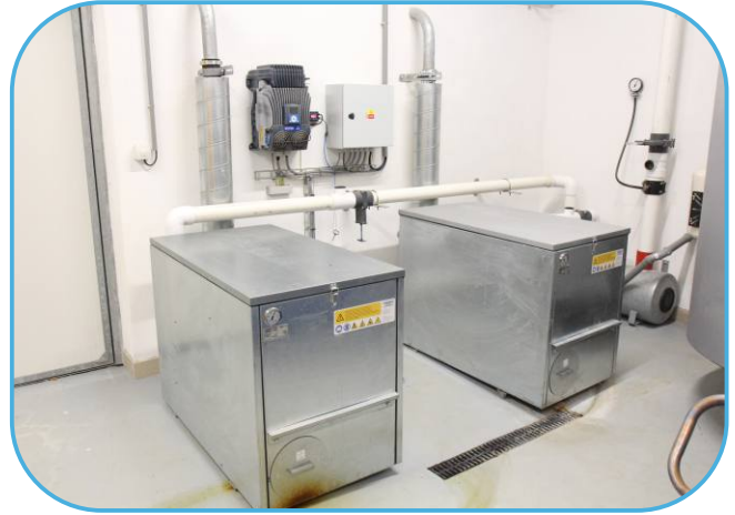
dmyhadla v izolovaných boxech s frekvenčním měničem
