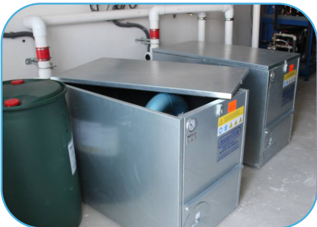
zdrojem podtlaku jsou dmychadla s frekvenčním měničem
