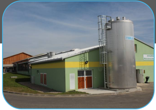
pohled na budovu dojírny a čekárny dojnic
