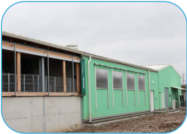
na dojírnu navazuje čekárna dojnic
