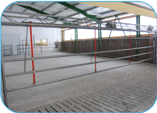
přihaněč dojnic v čekárně
