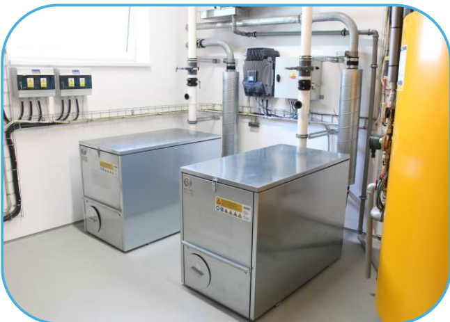
dmychadla v izolovaných boxech s frekvenčním měničem
