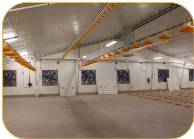
štitové odťahové ventilátory
