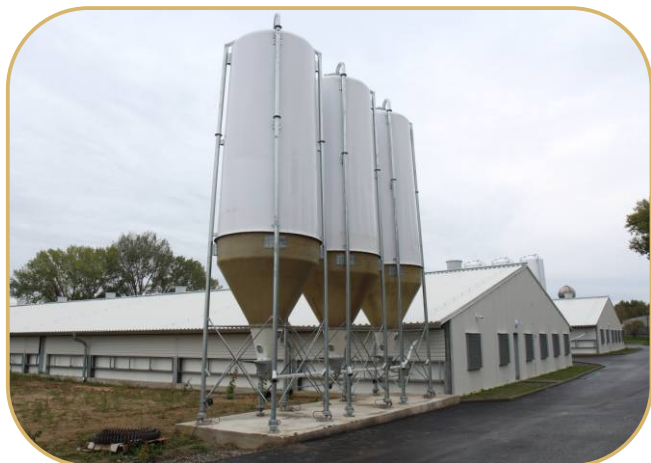
sklolaminátové zásobníky na tenzometrech
