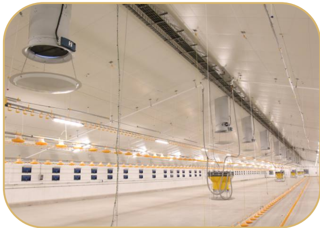
odtahové komíny a teplovodní topidla CALORI-AIR
