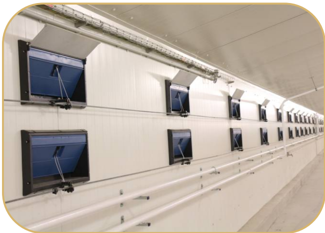
stěnové přívodní klapky
