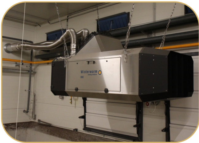
plynové topidlo DXC s nepřímým spalováním WinterWarm
