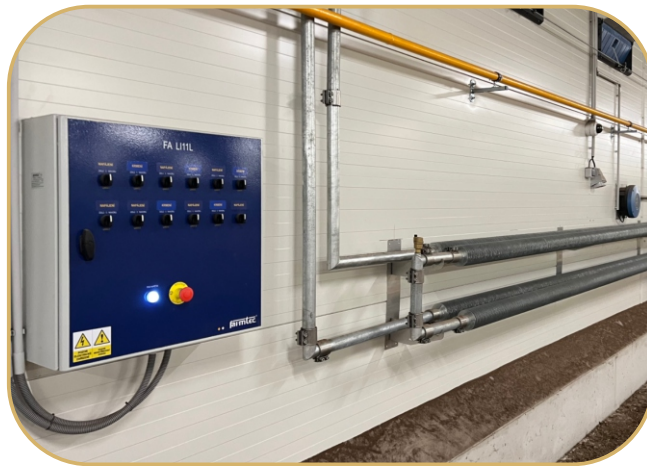
ovládací skříň pro zvedání krmných a napájecích linek
