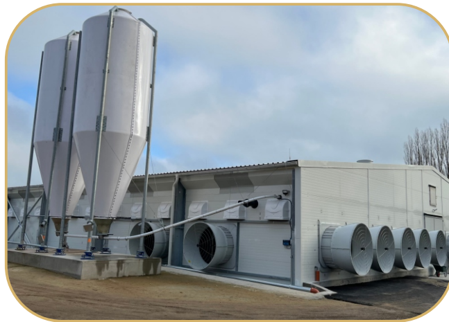
zásobníky krmiva na tenzometrech, štítové ventilátory
