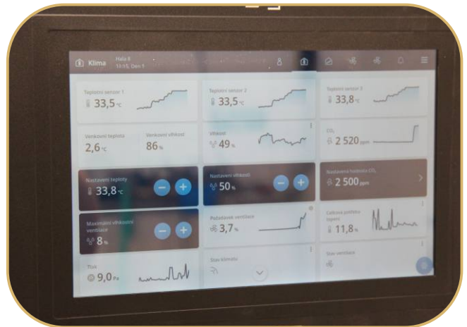
detail displeje klima a produkčního počítače
