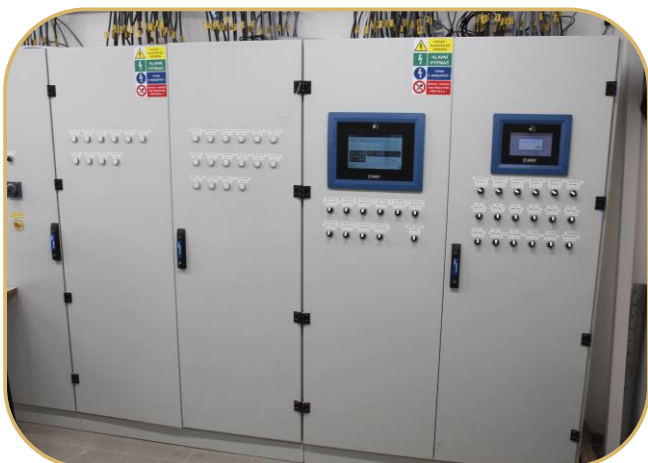
elektrický rozvaděč s integrovanými ovládacími prvky
