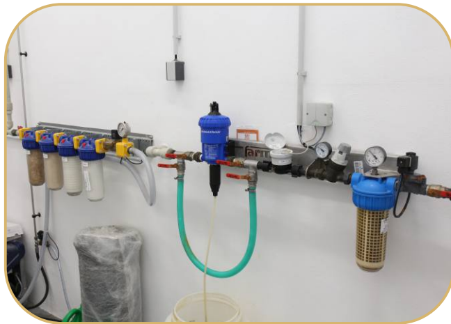
uzel s medikátorem pro systém napájení
