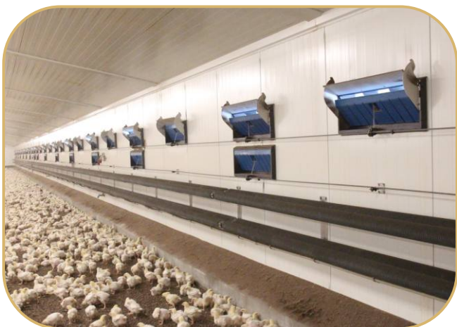
stěnové přírodní klapky, teplovodní vytápění
