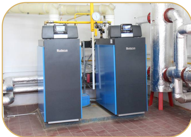
automatické plynové kotle
