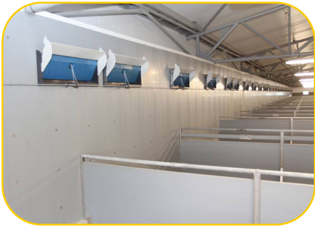
stěnové přívodní klapky
