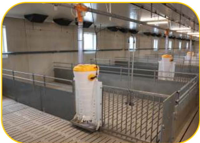
hala se suchým krmením
