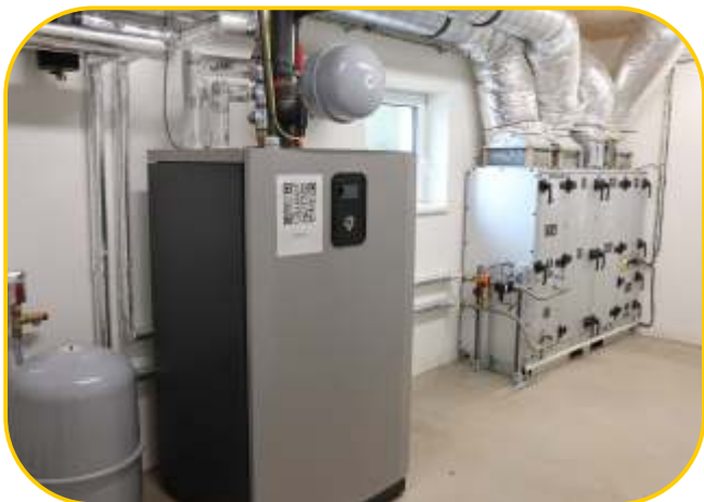
tepelné čerpadlo odebírá teplo z kejdy
