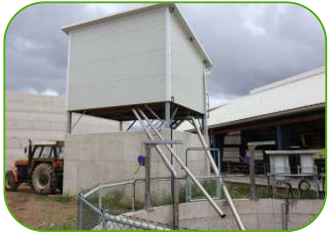
skladovací a čerpací jímka na kejkdu a budova se separátorem
