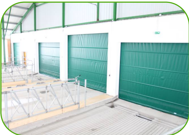
propad do kejdrového kanálu na konci stáje
