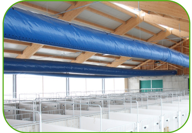
tubusová ventilace zajišťuje snížení infekčního tlaku
