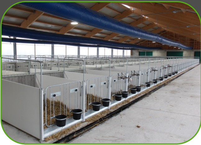
podlahy stáje jsou spádované k podélným žlábkům
