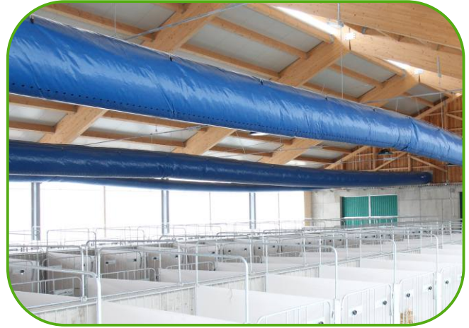
tubusová ventilace zajišťuje snížení infekčního tlaku
