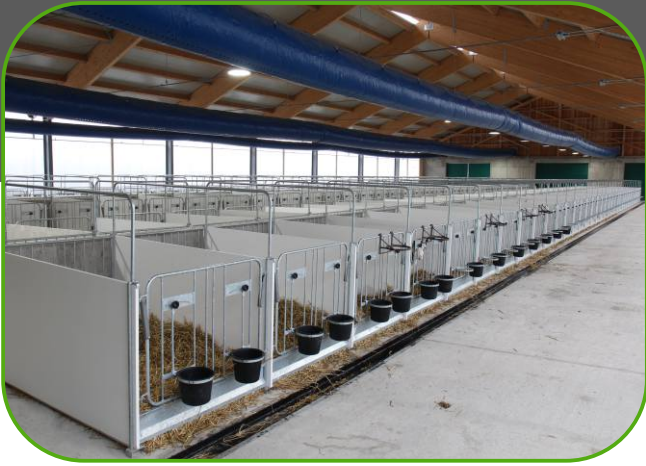
podlahy stáje jsou spádované k podélným žlábkům
