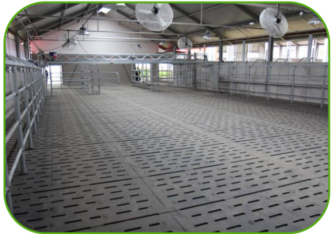
zarošovaná čekárna s gumovým povrchem a přihrádkem
