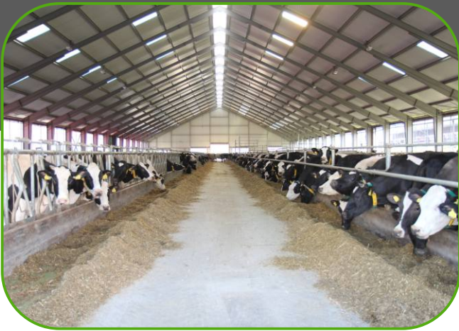
bezsloupová ocelová konstrukce
