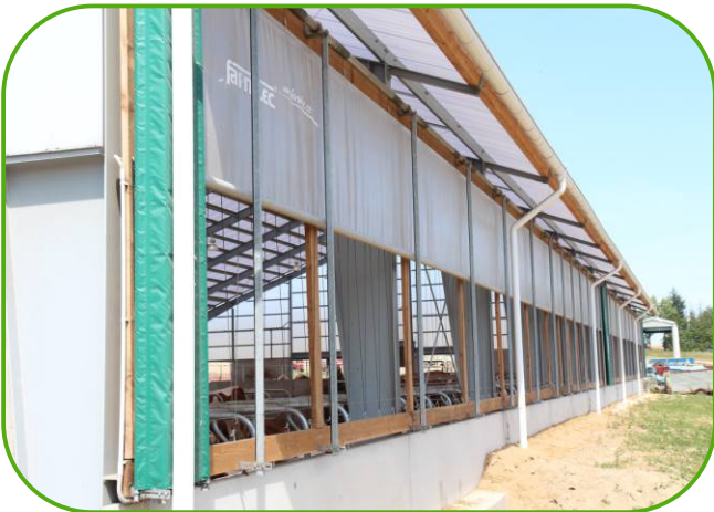
boční svinovací plachty na bocích stáje
