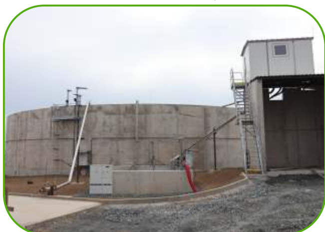
skladovací jímka na kejdu a budova se separátorem
