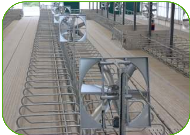
ventilátor ADF s plynulou regulací
