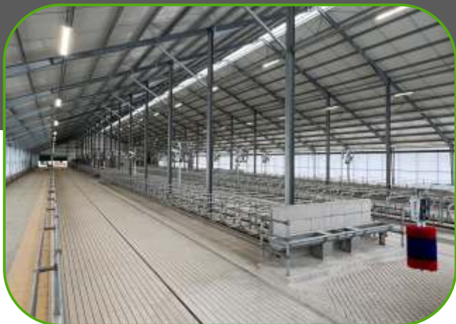
šestiřadé uspořádání stáje, lehací boxy s prsní opěrkou
