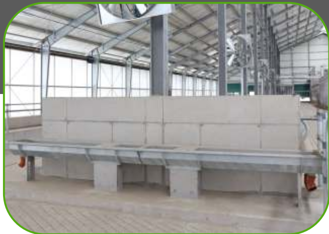
nerezové vyhřívané napájecí žlaby, typ Jupiter DUO
