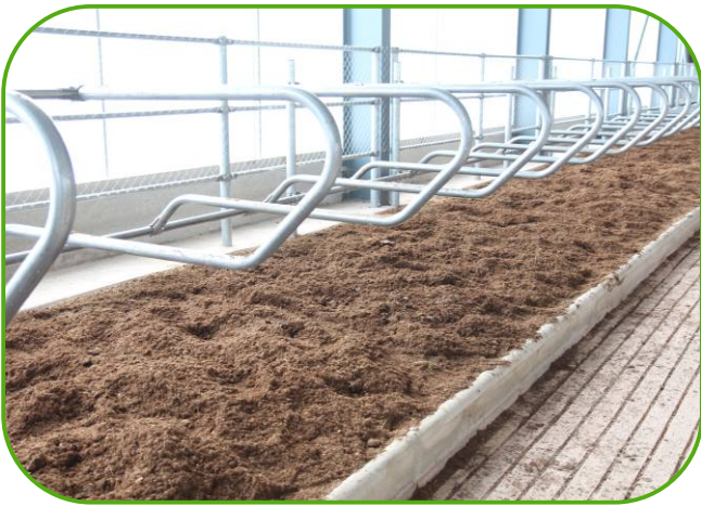
lehací boxy pro dojnice
