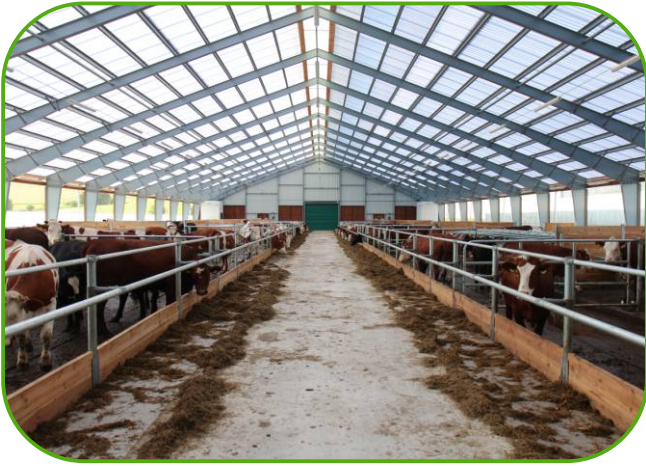
bezsloupová ocelová konstrukce stáje
