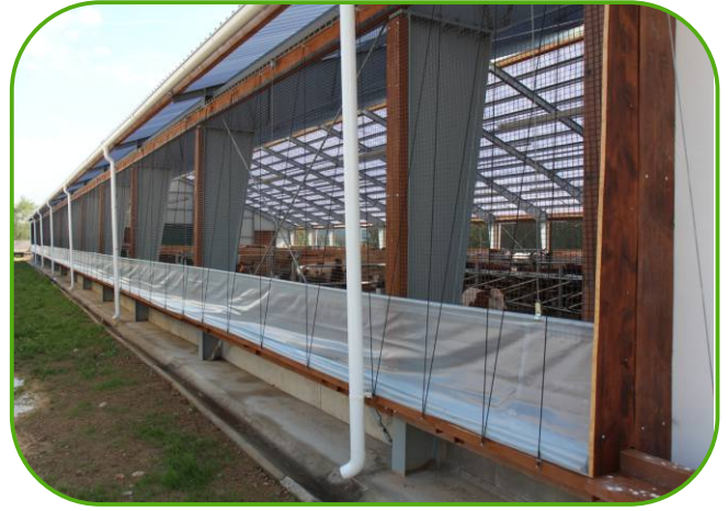
otevřené boční stěny se svinovacím iplachtami
