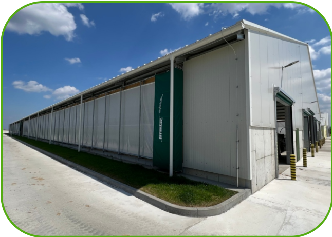
systém A-TECH ovládá osvětlení, ventilátory a boční plachty
