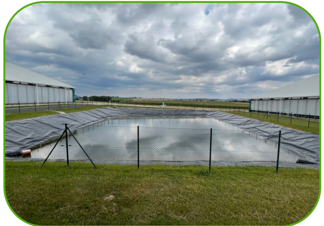
retenční nádrž na dešťovou vodu
