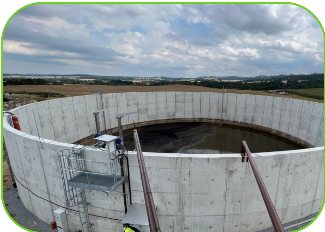
skladovací jímka na kejdu s míchadly a čerpadly
