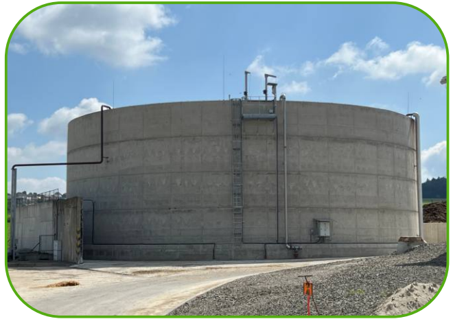
skladovací jímka na kejdu s míchadly a čerpadlem
