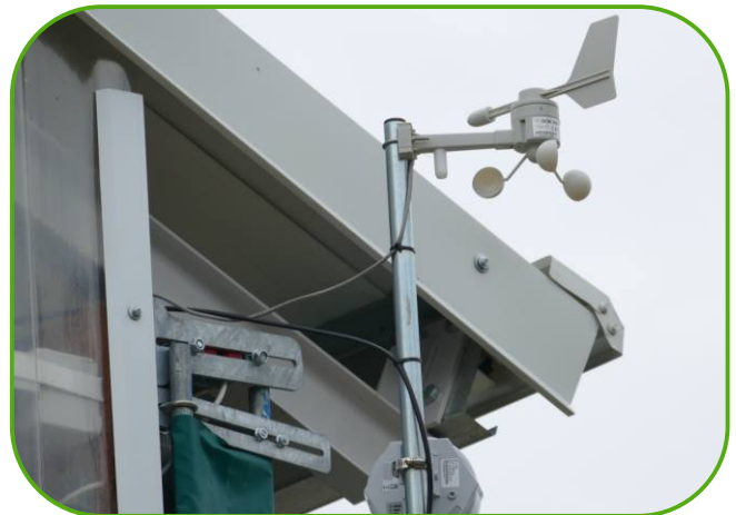
data z meteostanice využívá ASŘ
