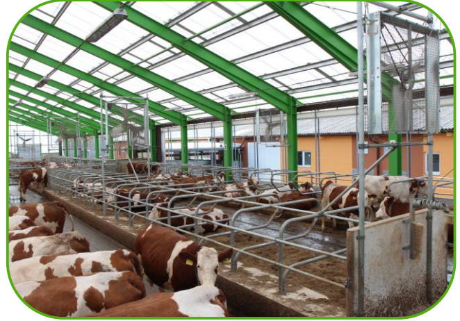
axiální ventilátory nad ležacími boxy
