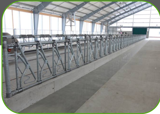
fixační žlabové zábrany
