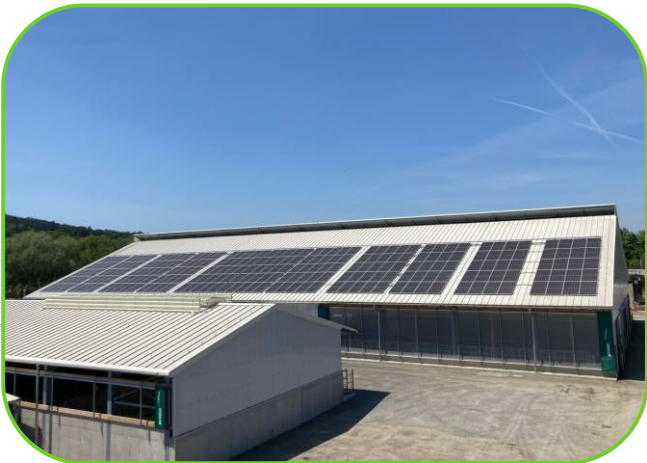
FVE o výkonu 428,92 kWp, boční svinovací plachty
