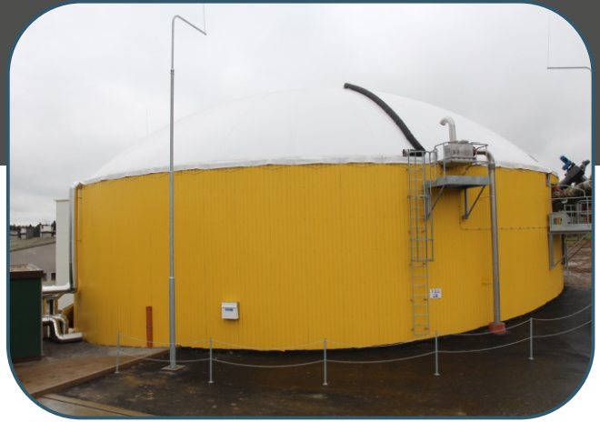
kapalinová tlaková pojistka plynu
