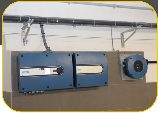
klimapočítače (vlevo) a servomotor stěnových klapky
