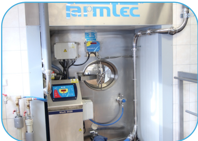
mléko je uchováváno ve vertikálním sile
