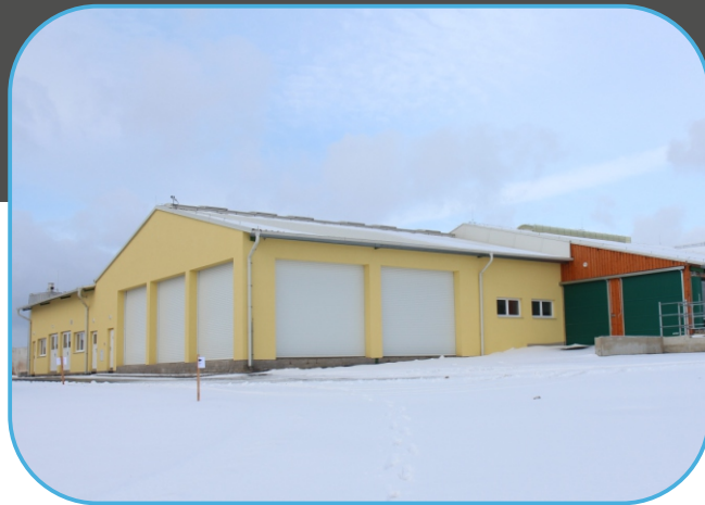
boční stěny dojírny jsou otevíratelné
