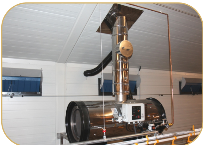
topidlo BH 50 s přívodem vzduchu a odvodem spalin
