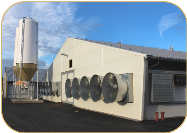
konec haly se štítovými ventilátory a zásobníky
