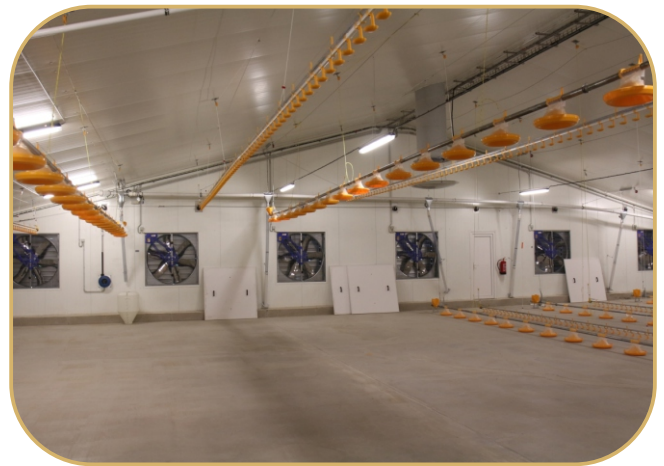
štitové odtahové ventilátory
