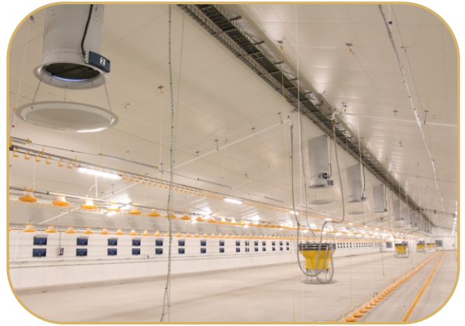
odtahové komíny a teplovodní topidla CALORI-AIR
