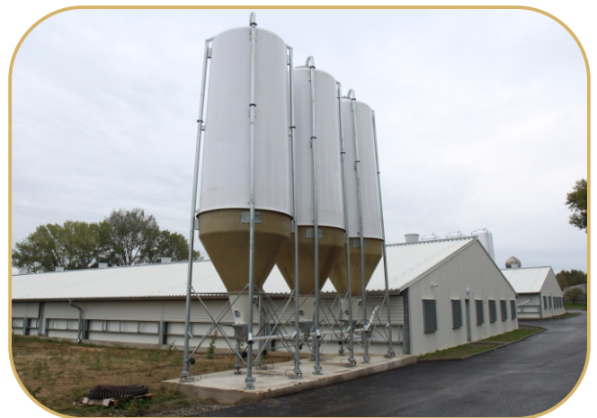
sklolaminátové zásobníky na tenzometrech
