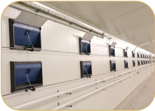
stěnové přívodní klapky
