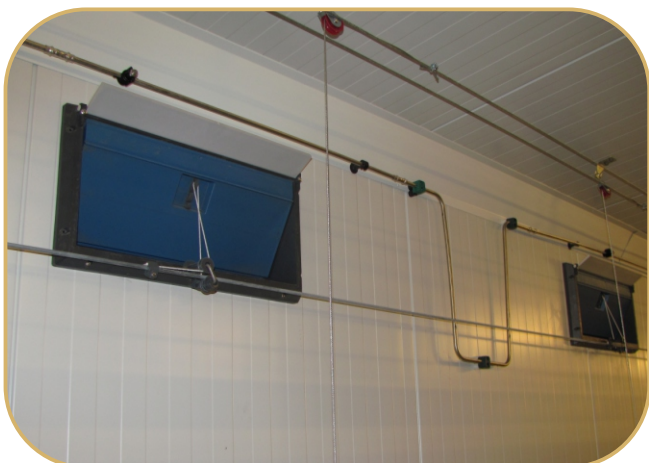
system vysokotlakého chlazení umístěný nad klapkami
