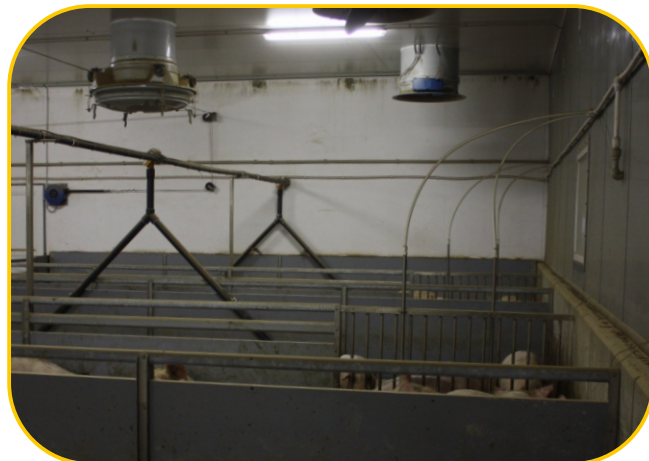
detail komínů (vlevo přívodní, vpravo odtahový)
