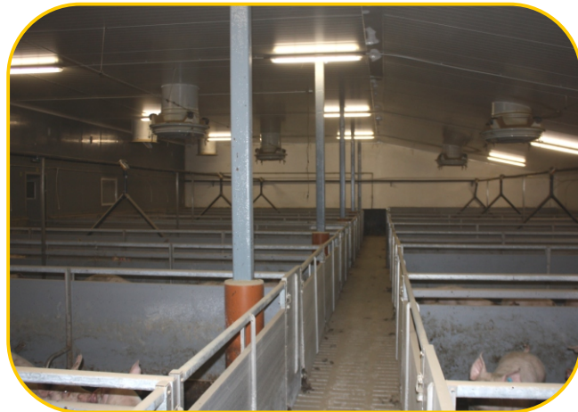
plastnerezové hrazení s polymerbetonovými koryty
