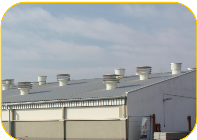
podtlaková ventilace s přívodními a odtahovými komíny
