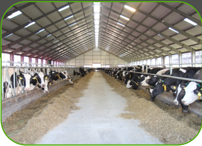
bezsloupová ocelová konstrukce
