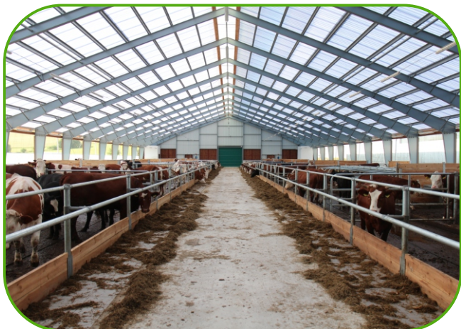
bezsloupová ocelová konstrukce stáje
