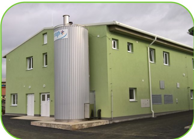
chladičí a skladovací silo na mléko
