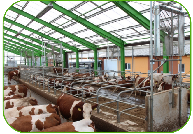
axiální ventilátory nad ležacími boxy
